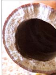
Photo 1 - Dépôts de tartre dans une canalisation
