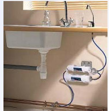
L'installation se réalise proche de l'évier de cuisine, le repiquage d'eau s'effectue simplement sur la canalisation d'eau froide alimentant cet évier et le purificateur possède son propre robinet de tirage d'eau purifiée.
